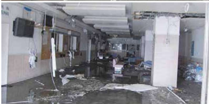
被災した石巻市立病院の様子 (提供：石巻市)
