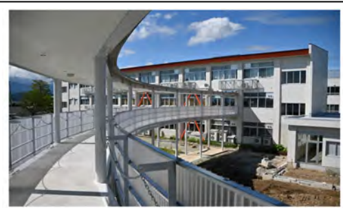
【図 13】 アリーナと本体（旧校舎） 2階をつなぐアプローチ
