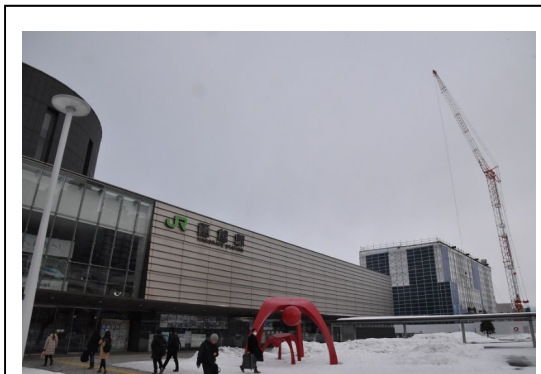
【図 29】 函館駅隣で建設が進むホテル
