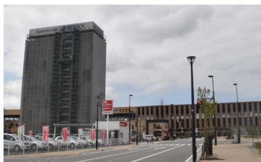
写真3 新高岡駅と建設中のホテル =2016年7月
